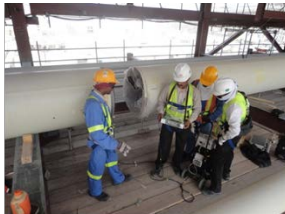
管内の状況をモニターで確認
