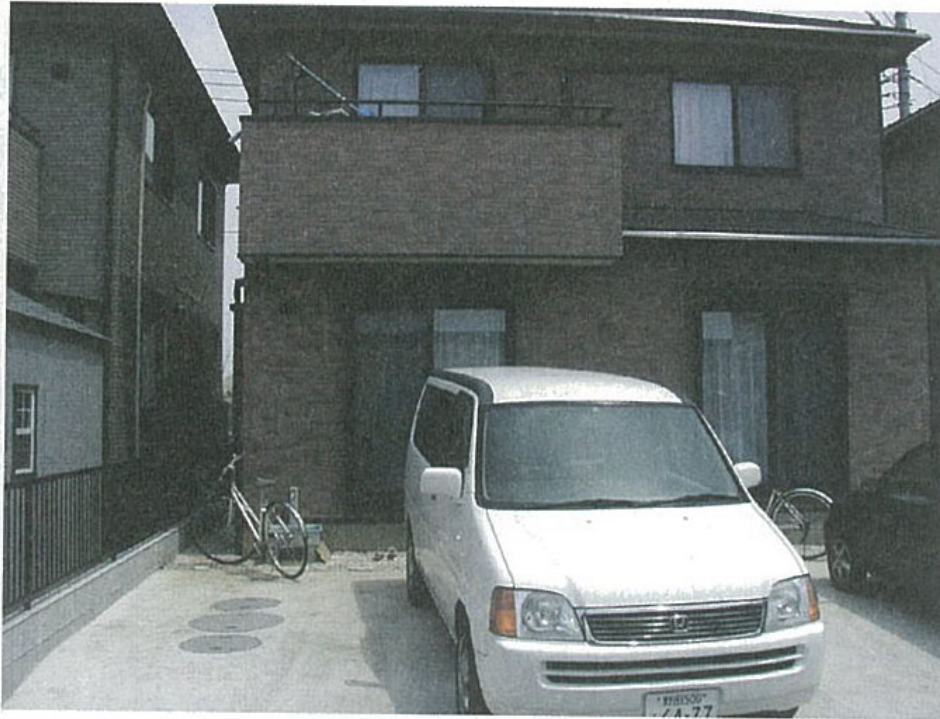
写真6-1 浄化槽の設置現場
