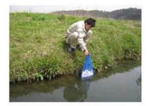
アミ袋に入れたアクアリフトを投入・設置します。 X槽・Y槽の流入側には槽の途中にぶら下がる位置に。 Y槽の下流側・Z槽には底に着くあたりに設置してください。
