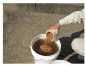
水に溶かして散布する場合には、現場の水を使用して 濃い目に溶かします。
