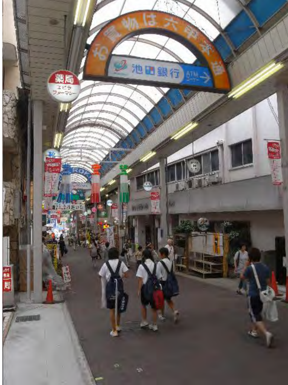
2008年時点の復旧した六甲本通商店街のアーケード
