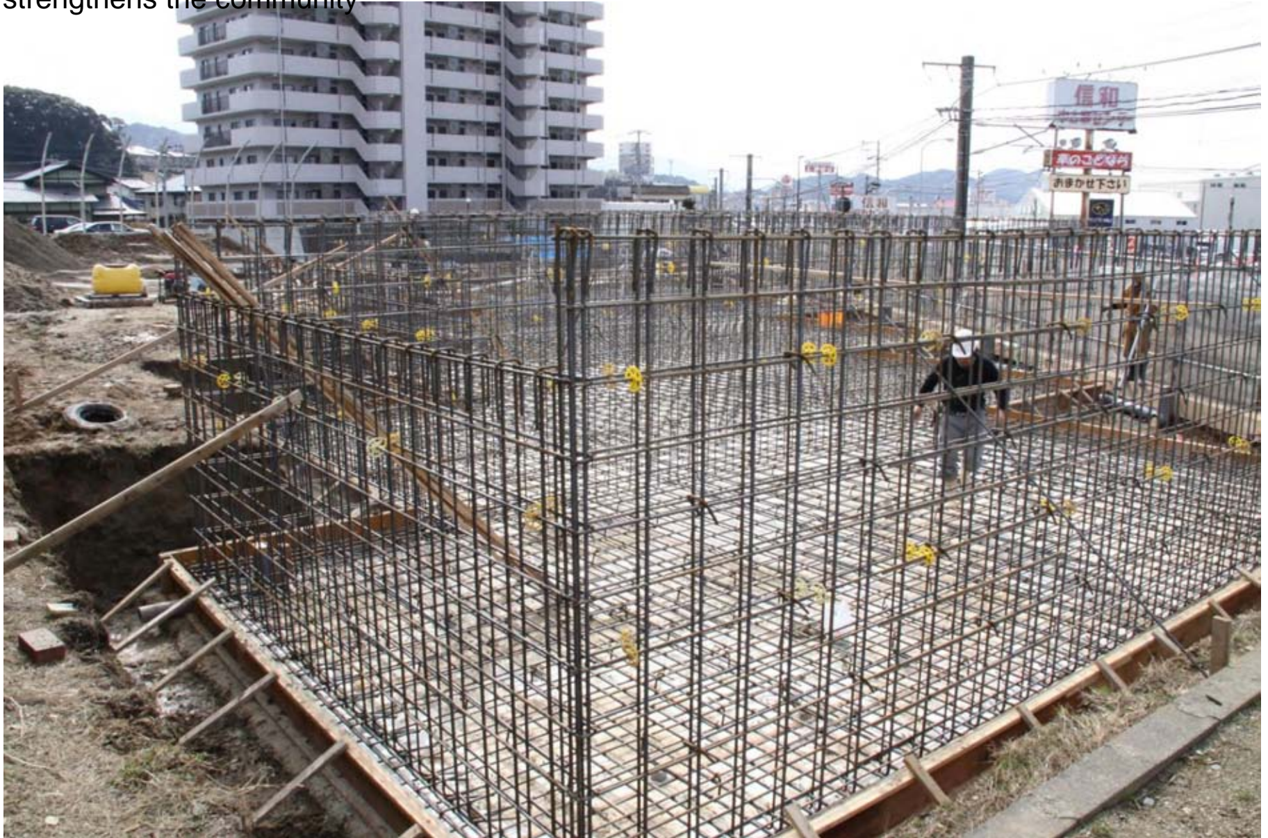
地下工作物の鉄筋組立ての様子
