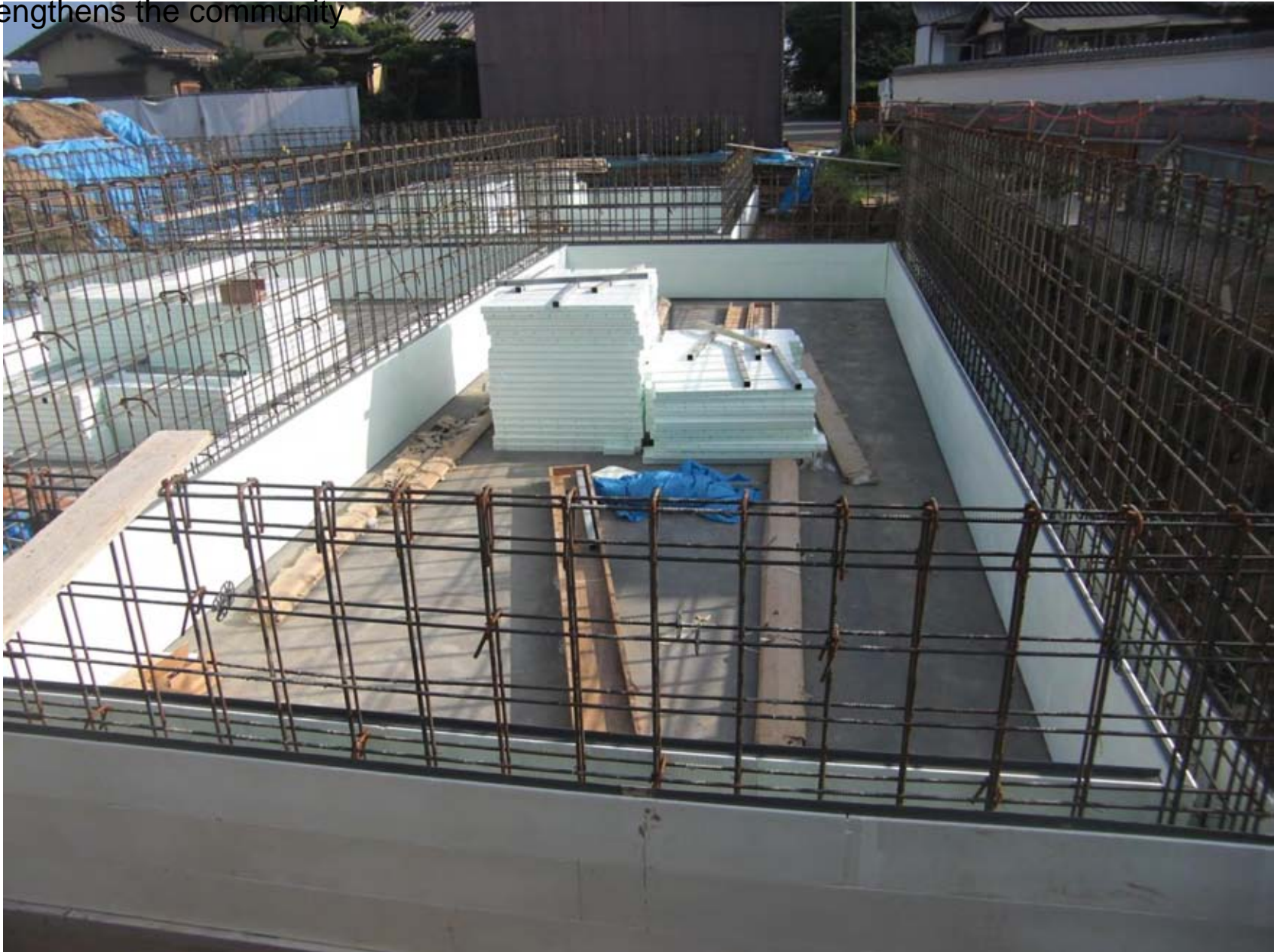
地下工作物の断熱型枠材を施工する様子
