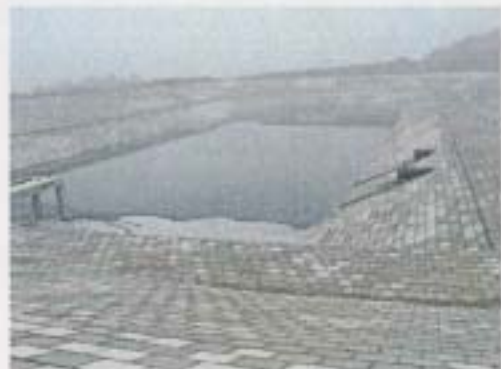
渗滤液调蓄池
