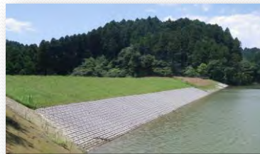
Miyazaki Pref (water reservoir)
