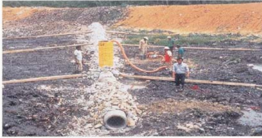
竹や廃ドラム缶を使った循環式準好気性埋立地
