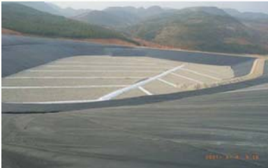
雲南省蒙自県で建設中の「福岡方式」埋立場 (2005年)
