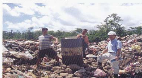
現地の技術者にガス抜管設置を指導 (2004年)
