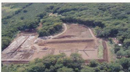
福岡方式に改善中の埋立場 (2003年)
