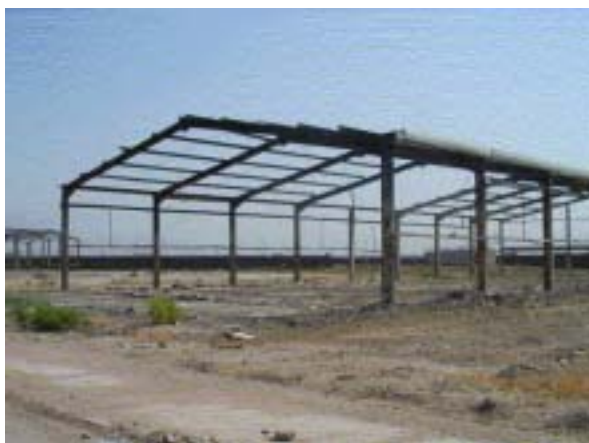
骨組み以外全て略奪されたバスラ技術大学の実習室
